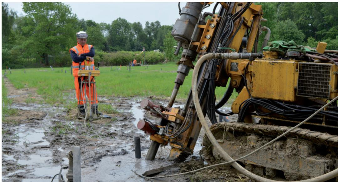
Die bis zu 30 Meter tiefen Bohr- und Verfüllarbeiten sind bald beendet.
