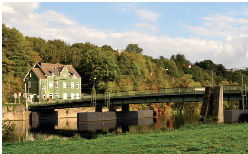
Die marode Pontonbrücke in Dahlhausen. Bald nur noch Geschichte?
