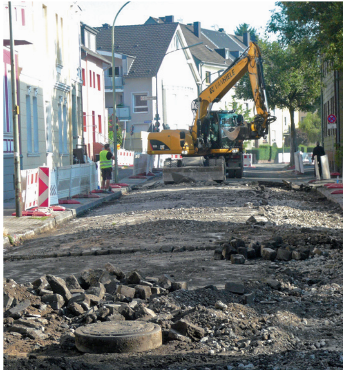
Aktuell machen die Bagger auf der Lindener Straße ihre Arbeit.
