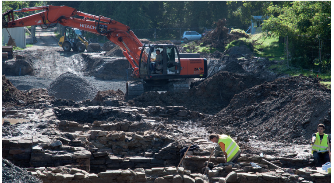
Während die Archäologen noch behutsam graben (vorne), sind die Bagger schon im Einsatz.
